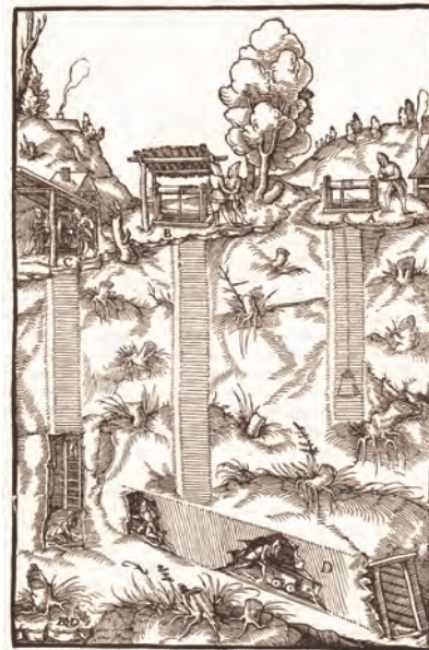
Do dolů horníci slézali po žebřících, spouštěli se na laněch nebo sjížděli skluzem na koženém fleku, který se stal typickou součástí jejich oděvu.
